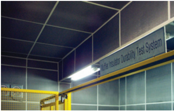
ESCO 실제 시공 사진
