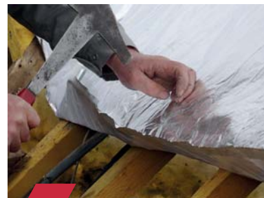
3 못(nail) or 함마타카(hammer tacker) 이용 고정 시킵니다.
