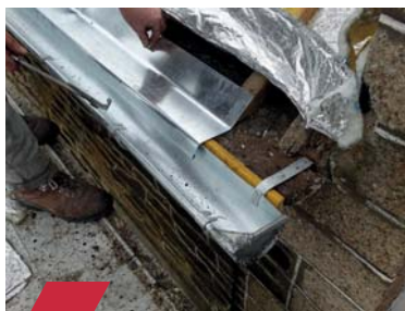
2 물받이 후레싱 (gutter flashing) 연결
