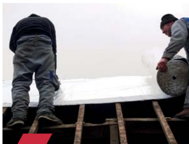
2 제품을 평평하게 펴서 평행을 유지 하며 서까래 (rafter) 위에 자리를 잡습니다. 검은 이음매 기준선을 참고합니다.
